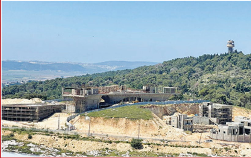
صورة لمشروع إقامة مبنى البلدية في يافة الناصرة
