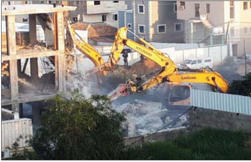
الجرافة تنفذ عملية الهدم - تصوير قسماوي نيت
